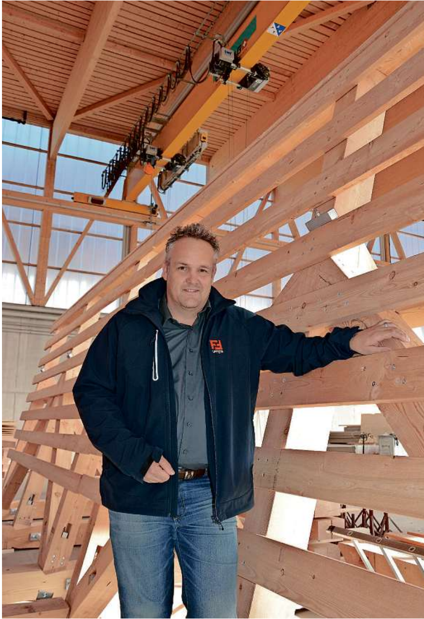
Lehrlingsprojekt in Savognin: Enrico Uffer vor der im Rahmen einer Projektwoche entstandenen Lawinerverbauung für Graubünden. Foto Norbert Waser
